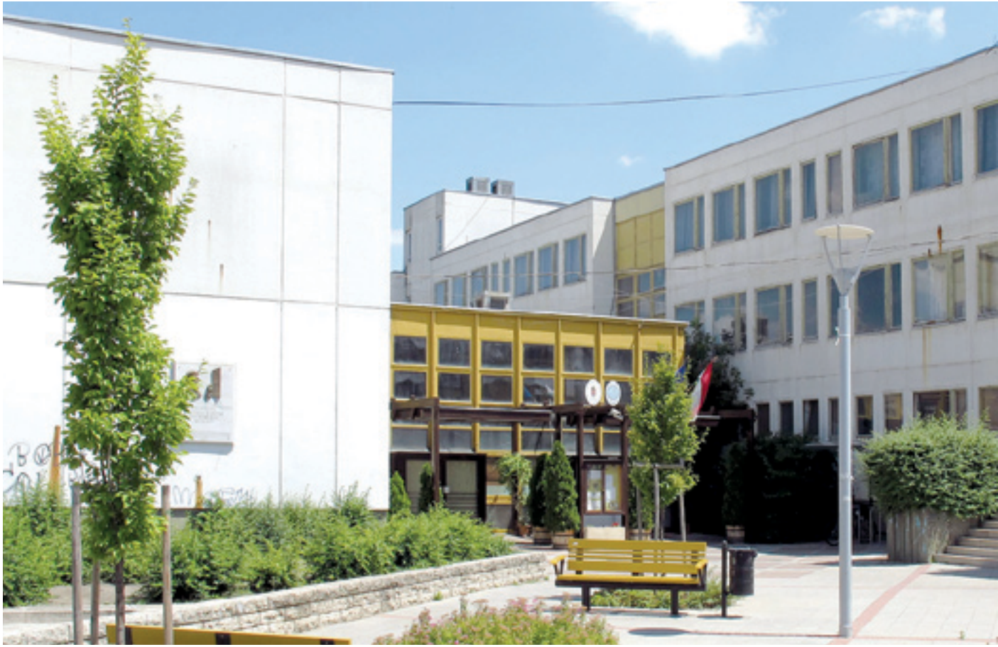
A Csontváros iskolában a tetőfelületet és a homlokzatot szigetelik, valamint új nyílászárókat és új radiátorokat szerelnek be
