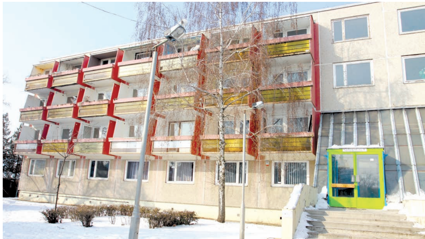
A Nagybecskerek utcában mindenki öröme megkezdődött a felújítás
