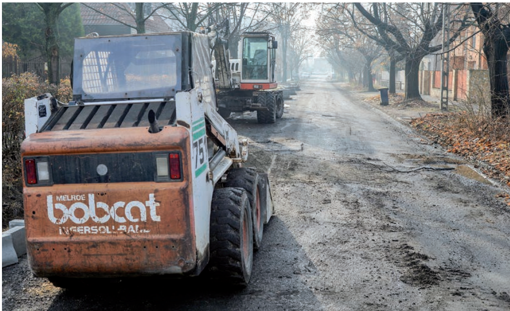
A Teleki utca felújítása az Üllői út és a Nefelejcs utca közötti szakaszon zajlik
