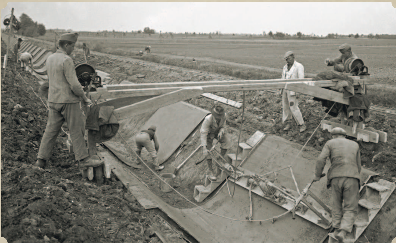
A tiszafüredi öntözőrendszer öntözőcsatornájának építése
