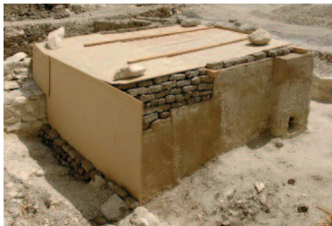
73–76. kép: A téglaszentély a részleges helyreállítást követően, illetve az ideiglenes védőburkolatban.
