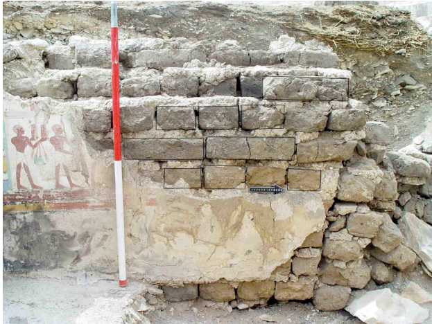
13. A vályogtégla szentély nyugati falának belső oldala, ahol a téglák körvonalai a téglarakás módját jelölik.
