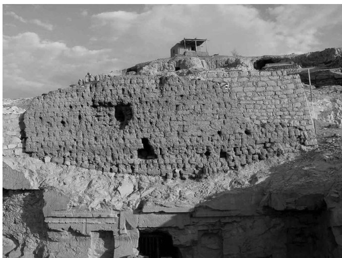
21. A Nebszumenu (TT 183) sziklahomlokzatát magasító vályogtégla fal délről. A fal jobb, keleti oldalát modern kőfallal egészítették ki.
