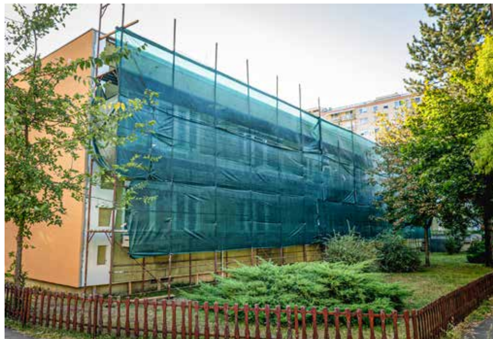
Energiatakarékos lesz az épület
