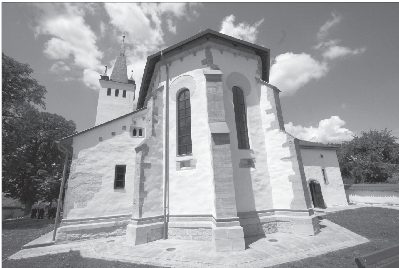
■ Foto 4. Fațada de nord-est după restaurarea din 2013-2015 © Ádám MAKSAJ
