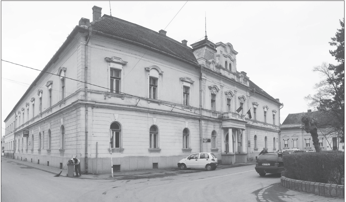
■ Foto 1. Fațada principală de nord-vest și fațada laterală de nord-est, Piața Trandafirilor ■ Photo 1. Main, north-western elevation and lateral north-eastern elevation, facing Trandafirilor Square
