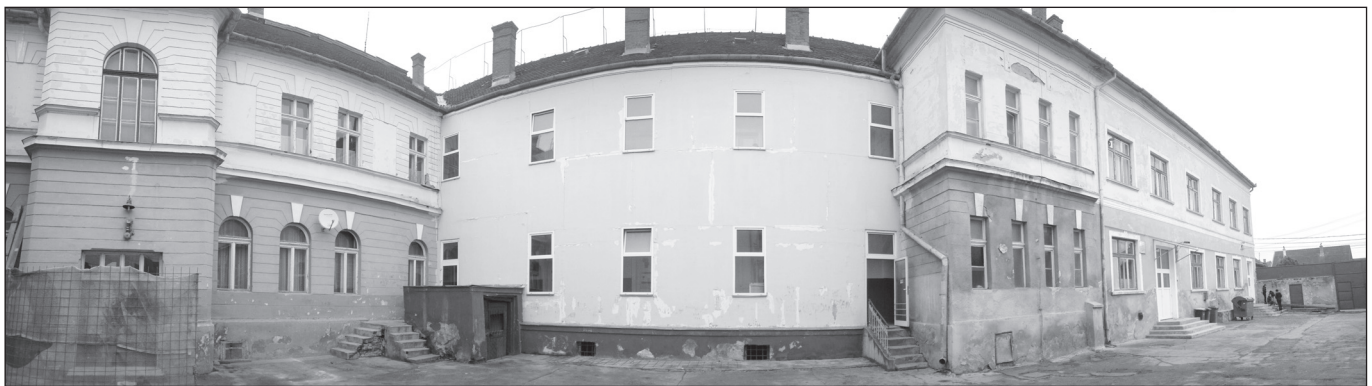
■ Foto 6. Fațada laterală spre curte – aripa stângă, închisă cu gipscarton și tâmplării din pvc cu geam termopan ■ Photo 6. Lateral elevation facing the courtyard – left wing, closed with plasterboard and PVC windows with double glazing
