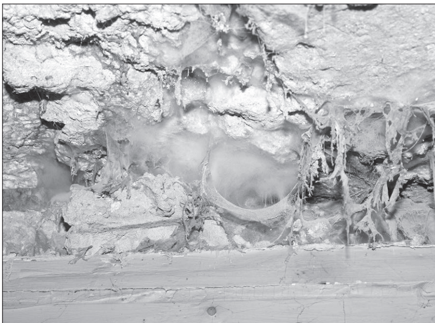
■ Foto 8. Miceliu proaspăt, dezvoltat în apropierea tâmplăriei ferestrelor © Octavian COROIU ■ Photo 8. Fresh mycelium, developed near the window joineries © Octavian COROIU
