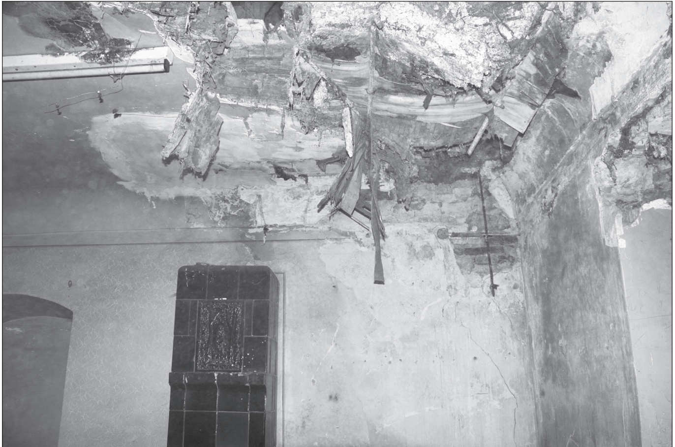
■ Foto 7. Planșeu degradat © Octavian COROIU
