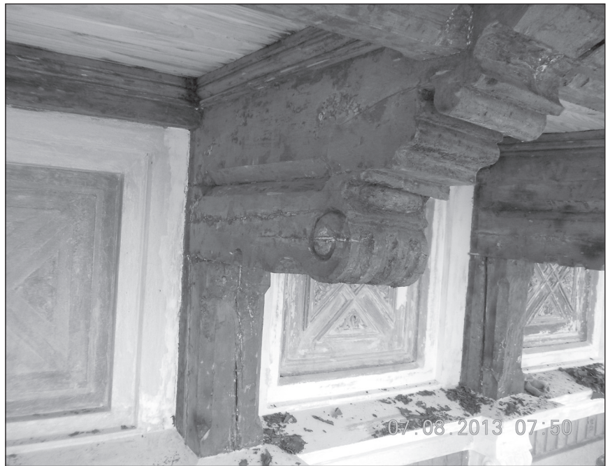
■ Foto 14. Intervenții asupra consolelor de la acoperișul corpului central
