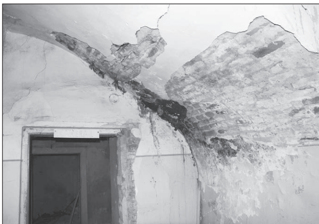
■ Foto 4. Corpuri sporifere îmbătrânite ale buretelui de casă (Poarta de Nord, Cetățuia din Cluj-Napoca, 2015) © Octavian COROIU ■ Photo 4. Old fructification bodies of Serpula lacrymans (North Gate, Citadel in Cluj-Napoca, 2015) © Octavian COROIU
