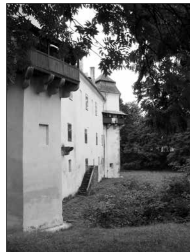
■ Foto 10. Latura nord-vestică a castelului © Andreea MILEA, 2009
