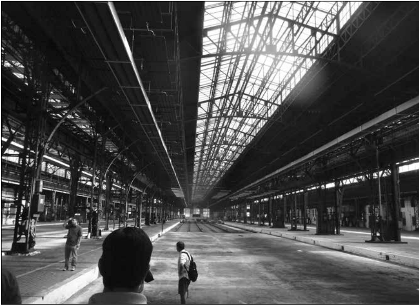
■ 2. kép: Az Eiffel-csarnok felújítás előtti belső képe © KAKASY László, BME Épületszerkezettani Tanszék ■ Photo 2. The interior of the Eiffel Hall before the renovation © László KAKASY, BUTE Department of Structural Engineering
