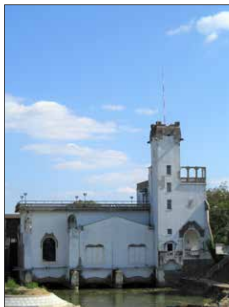
■ Foto 7. Centrala hidroelectrică din cartierul Fabric, monument istoric © Raluca-Maria TRIFA, 2015
