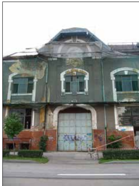
■ Foto 3. Fabrica de ciorapi în timpul operațiunilor de demolare – fațada principală © Raluca-Maria TRIFA, 2014
