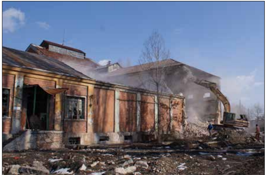
■ Foto 1. Fostul Combinat „Solventul”, în timpul operațiunilor de demolare a corpului principal © B. HAJDOT, 2012
