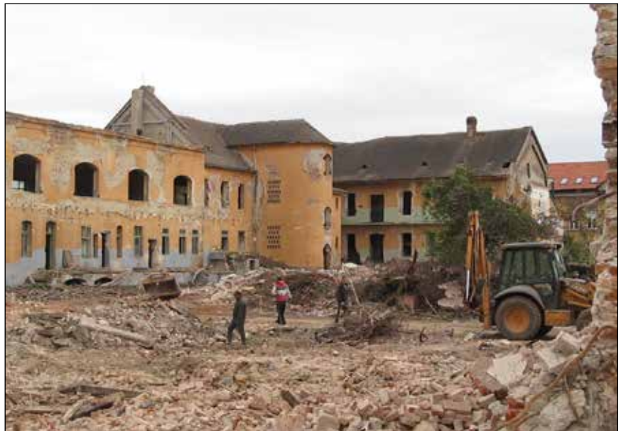
■ Foto 2. Fabrica de ciorapi în timpul operațiunilor de demolare (vedere din curte), pentru a face loc unui supermarket © Raluca-Maria TRIFA, 2014
