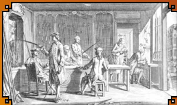
18. századi kardcszárműhely ábrázolása a francia Enciklopédiából . A kép bal oldalán a szúrásból való kihajlás vizsgálatát láthatjuk
