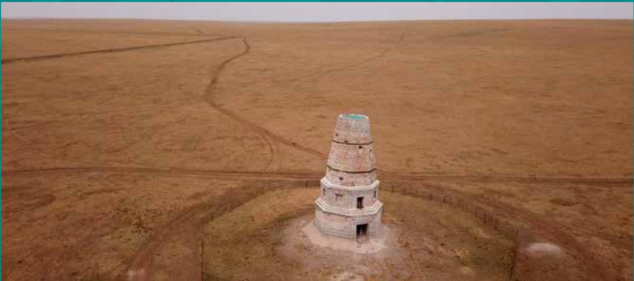
Kherlen Bars Khot 2015–2016-ban felújított sztúpa ja. A rekonstrukcióhoz helyben található anyagokat használtak, az agyagtégglák égetéséhez egy ideiglenes kemencét is készítettek. Egyes korai leírások szerint a területen állt egy másik sztúpa is, ami vélhetően az 1950-es évek körül omolhatott össze
