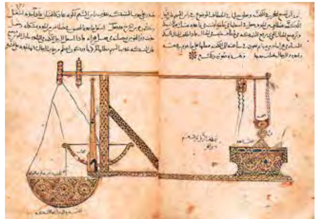
Mardí ibn 'Alí al-Tarsúsi által 1187-ben készített illusztráció egy ellensúlyos hajítógépről
