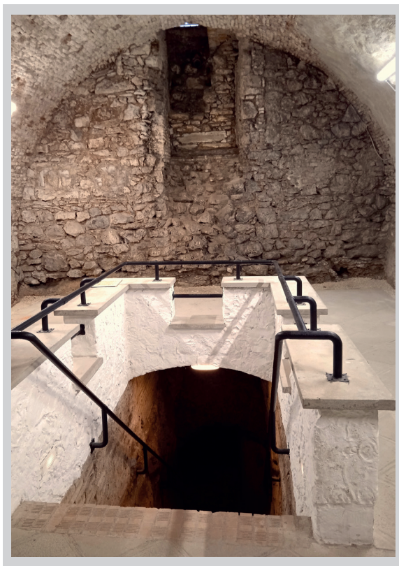
5. ábra. Szerkezeti pince befalazott hordóleeresztő nyílással és a barlangpincébe vezető lépcsővel (fotó: Szent Tamás)
