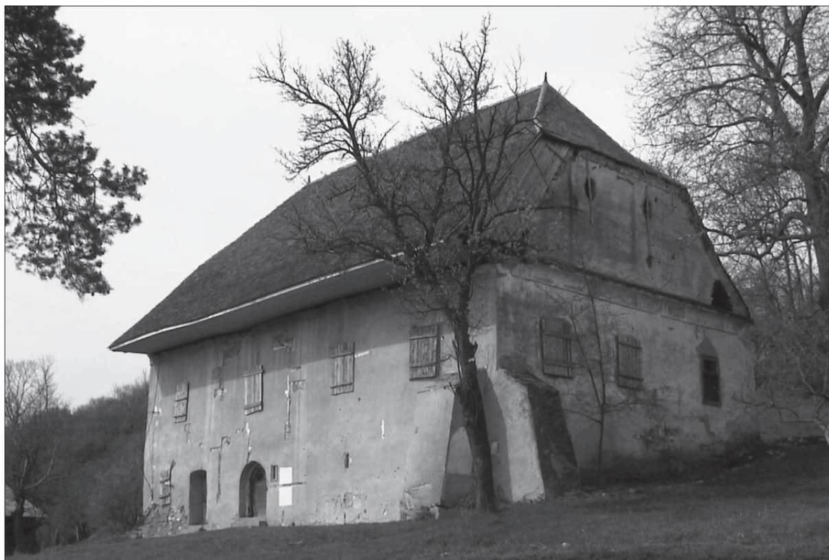
2. ábra A kúria északkeleti homlokzata.
