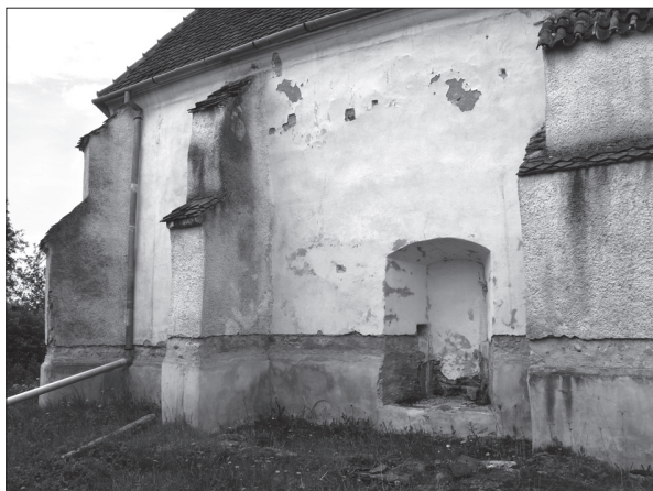
17. ábra Az északi homlokzat a befalazott sekrestyenylással és gerendaüregével.
