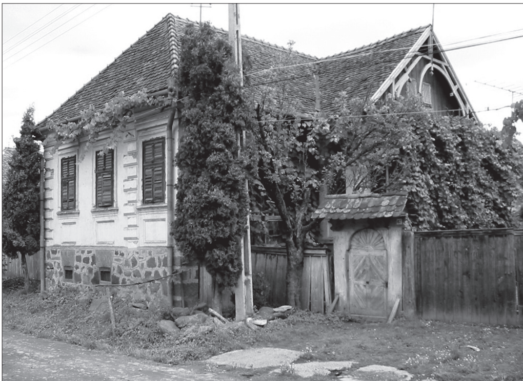
Figura 11 Călugăreni, str. Principală nr. 67, fațada dinspre stradă
