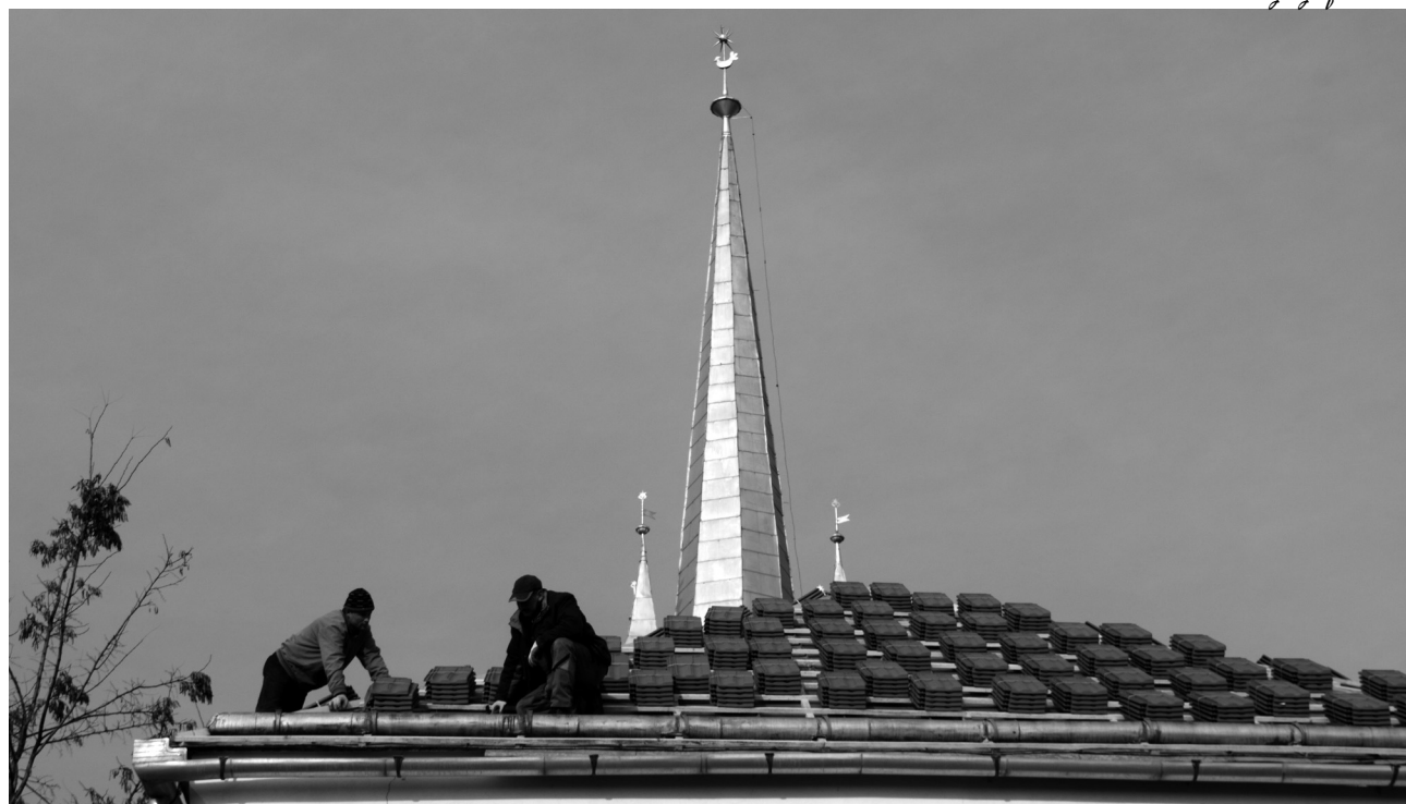
Elodázhatatlan volt a templomtető újracserépezése
