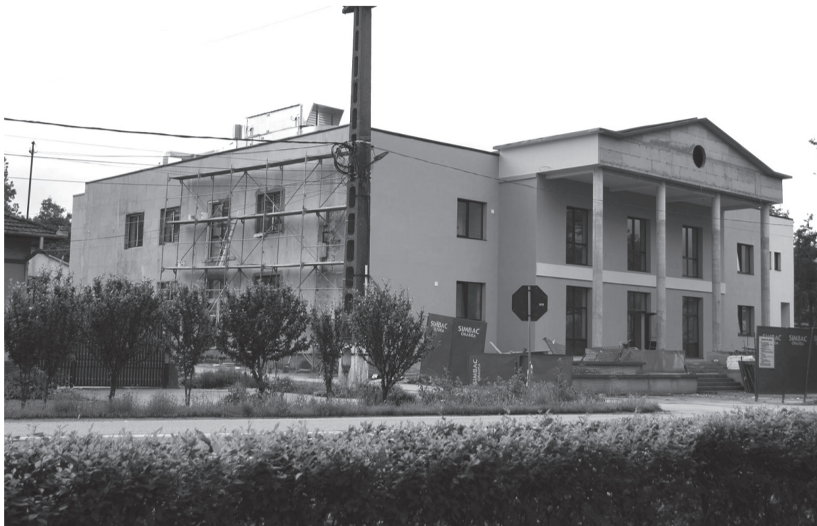
A kulturális központ épülethomlokzata már új köntösbe öltözött
