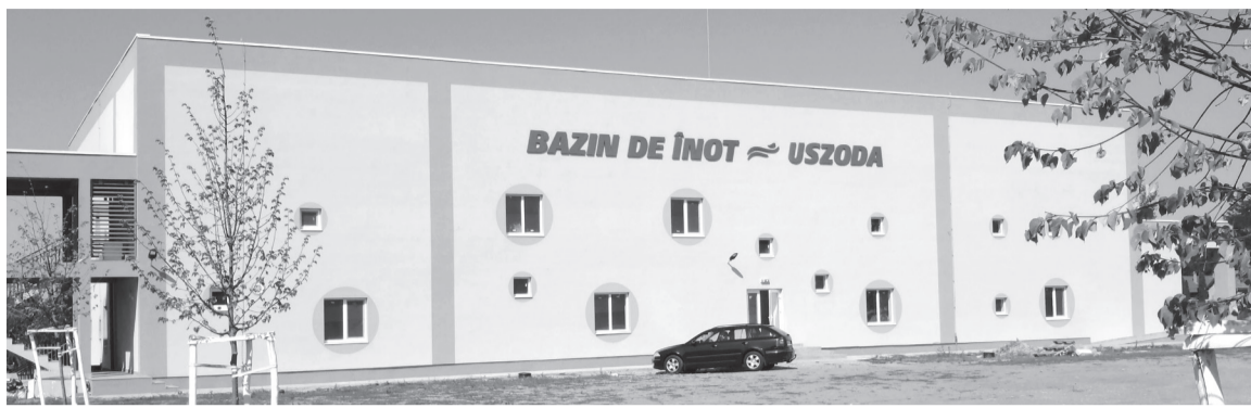
Közeledik a tanuszoda épületének befejezése
