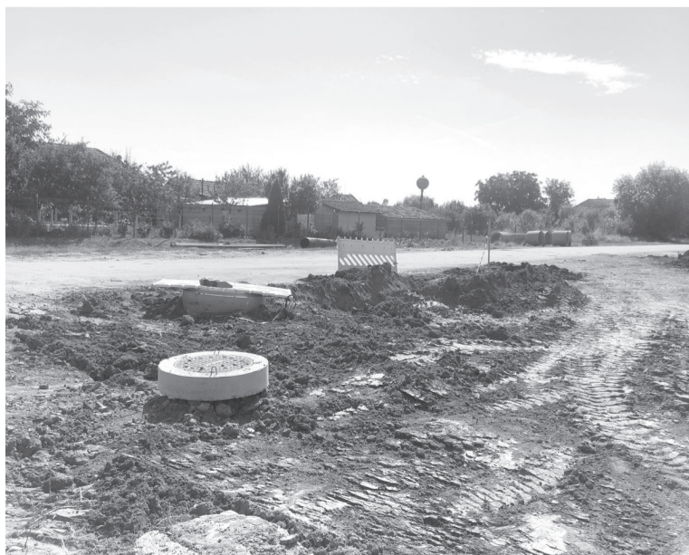
A csatornázás során több mint 12 kilométernyi vezeték fektettek le, a feltúrt utakat, járdákat kijavítják
