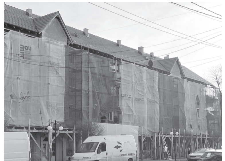
Zajlanak a tömhházak külső felújítási munkálatai
