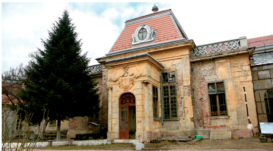
A kastélyépület másik homlokzata még felújításra vár
