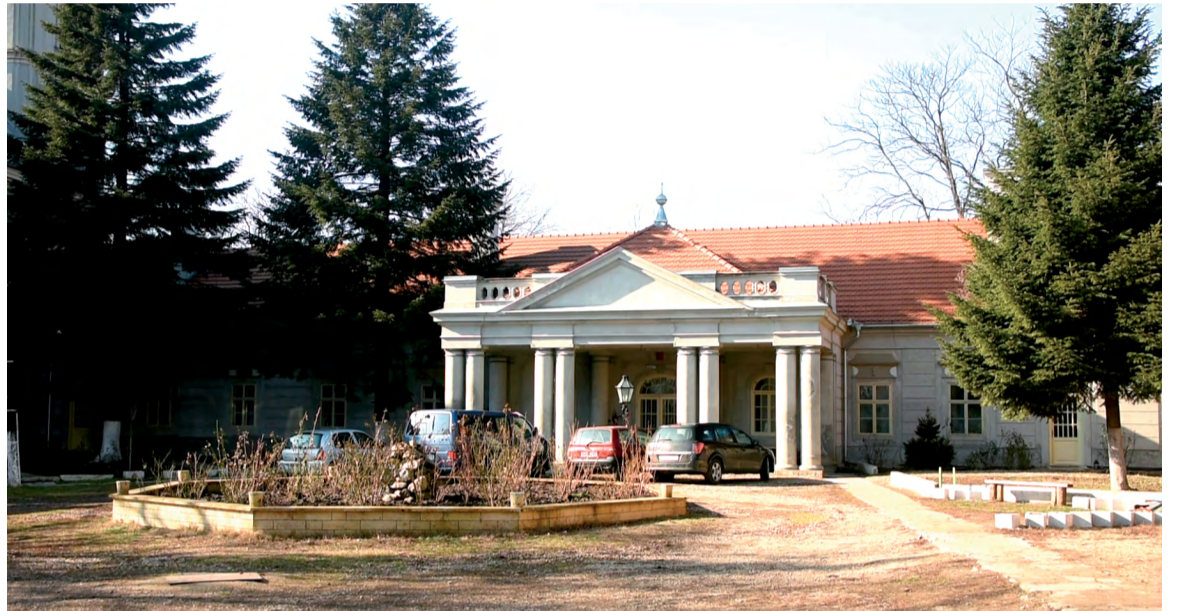
Az épület főhomlokzatát részben már évekkel ezelőtt felújították
