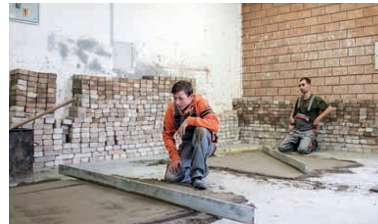
Kőműves és hidegburkoló szakos tanulók az aljzatkiegyenlítést gyakorolják. Erre teszik majd a burkolatot. Mesterük az iskola alakulása óta – 25 éve – itt tanít.
