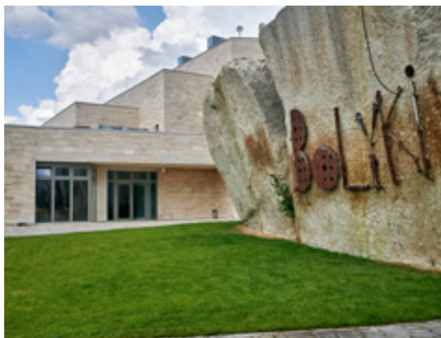
Jani szerint amióta a borokat a 2020-ban befejezett új üzemben készítik, „sokkal finomabbak”. A modern épület gondos tervezőjének köszönhetően a riolittufa bánya vonalaival is harmonizál
