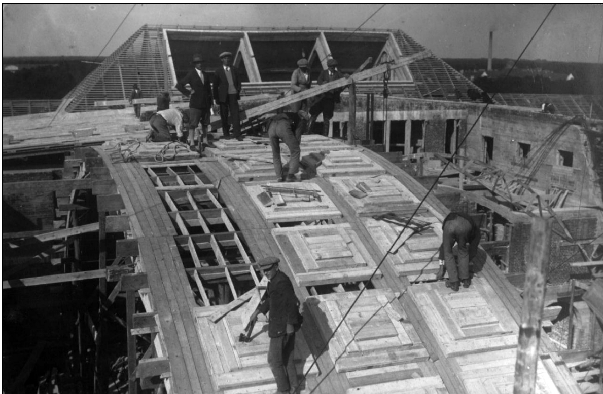
6. kép A Debreceni Egyetem Központi épülete kivitelezés közben V. 15
