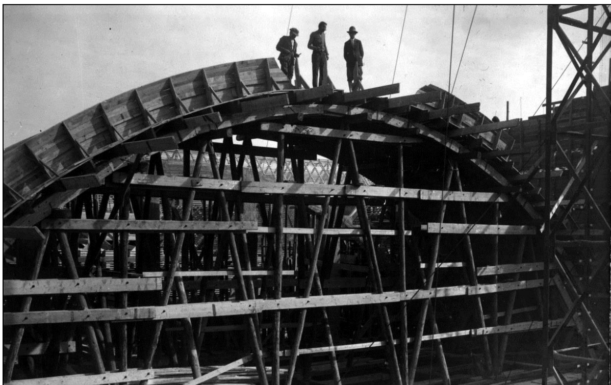
5. kép A Debreceni Egyetem Központi épülete kivitelezés közben IV. 12
