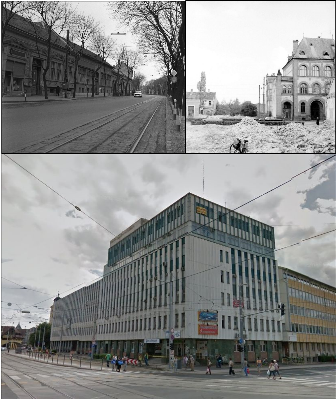
4-6. kép A Péterfia utca 8. számú ház – a kép bal felső oldalán –, majd az 1975-ös bontás előtt – a kép jobb felső oldalán –, ahol még éppen látható az épület falazata. Később a jelenleg is álló Szövetkezeti székházat emelték a helyére 25
