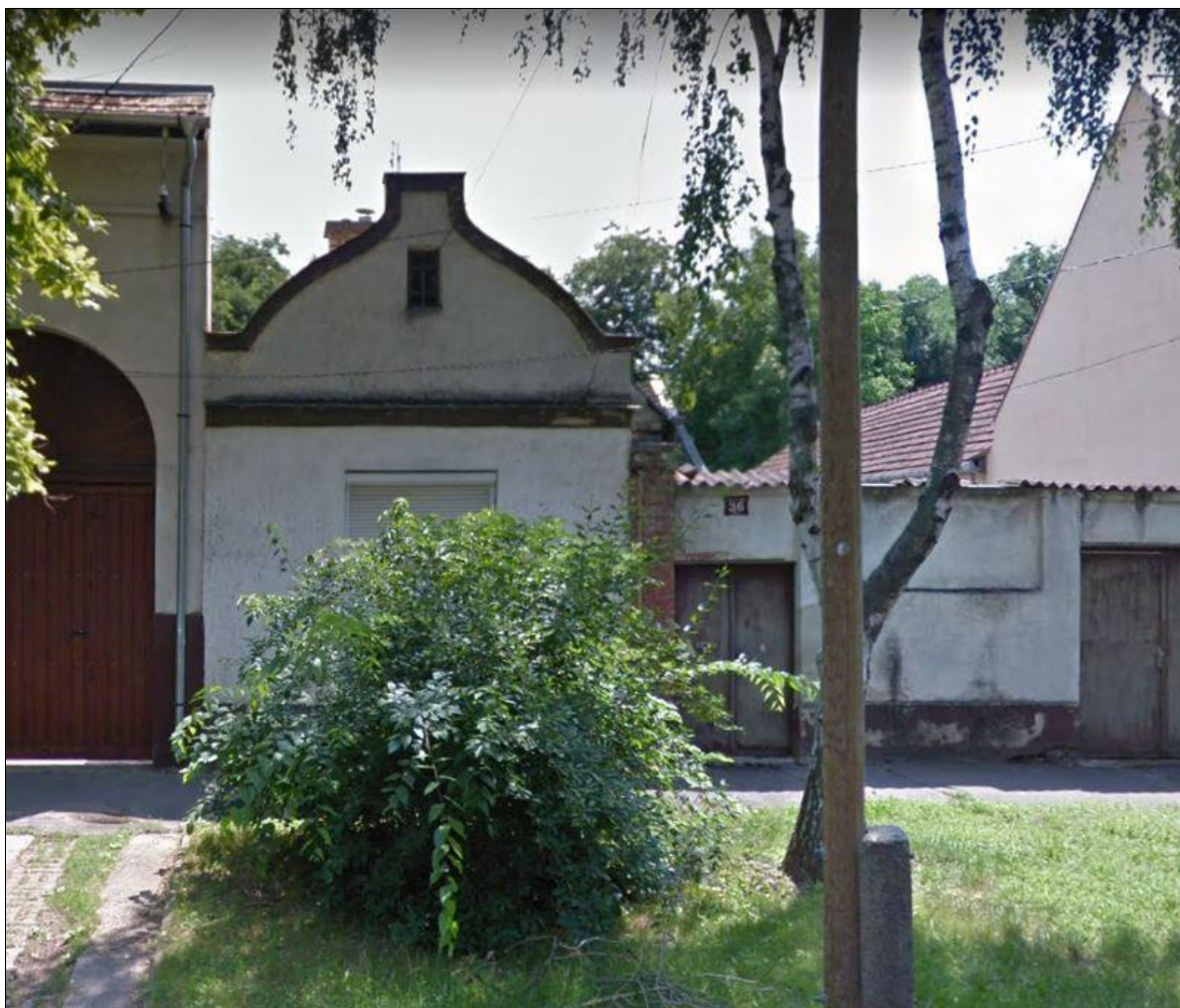
7. kép Úgynevezett hattyúszárnyív oromzatos taksás ház, amely nagy valószínűséggel a legrégebbi ilyen jellegű épületünk. Valamikor 1752-1783. között valósulhatot meg. Megjegyzés: Lásd az előző képen kék színnel jelölve 9
