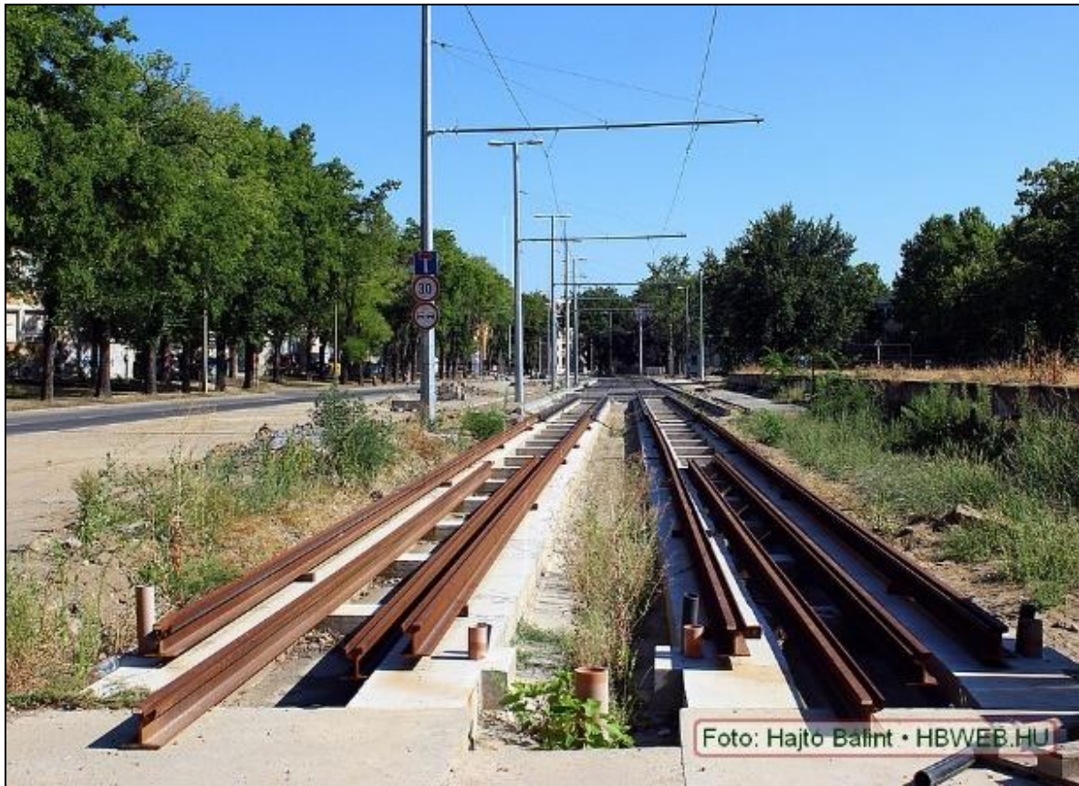
26. kép Életképek a villamosvonal építéséből 46
