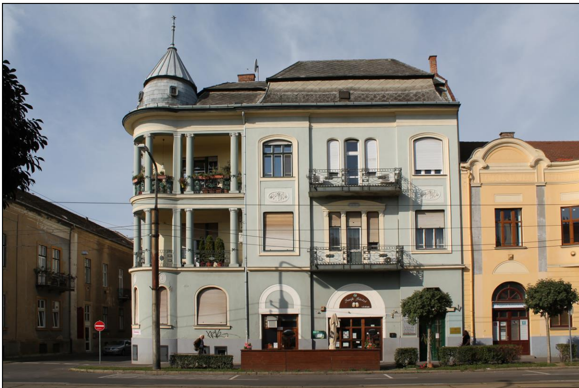
30. kép A Wolff ház Péterfia utca felőli főhomlokzata 58
