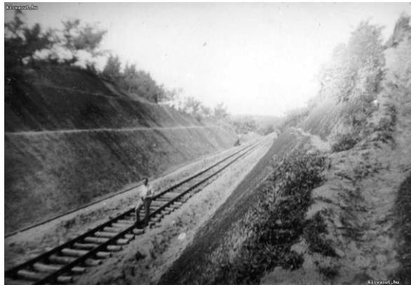
8. kép Vasútépítés Hármashegyialján ( https://www.kisvasut.hu/keret/showpic.php?kod=12172 )
