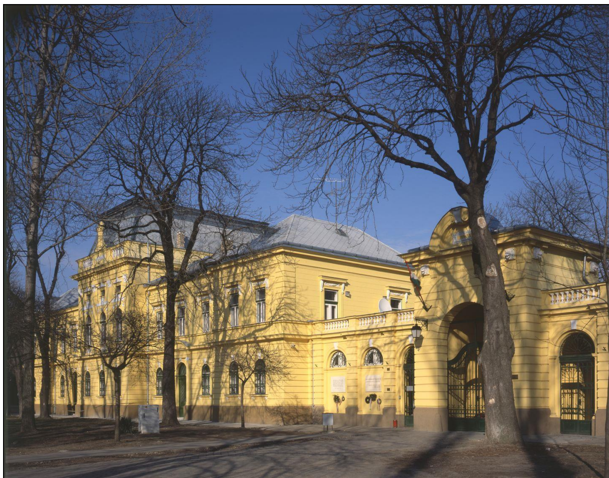
30. kép A volt Tiszti-lak – most 1. jelű igazgatási blokk helyreállított épülete 2022-ben 51
