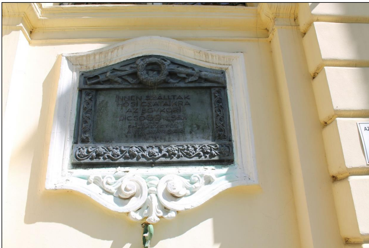
18. kép A 39-es Gyalogezred emléktáblája a Pavillon laktanya/Kossuth Lajos Gimnázium épületének homlokzatán. Debreczeni Tivadar alkotása 1926-ból 37
