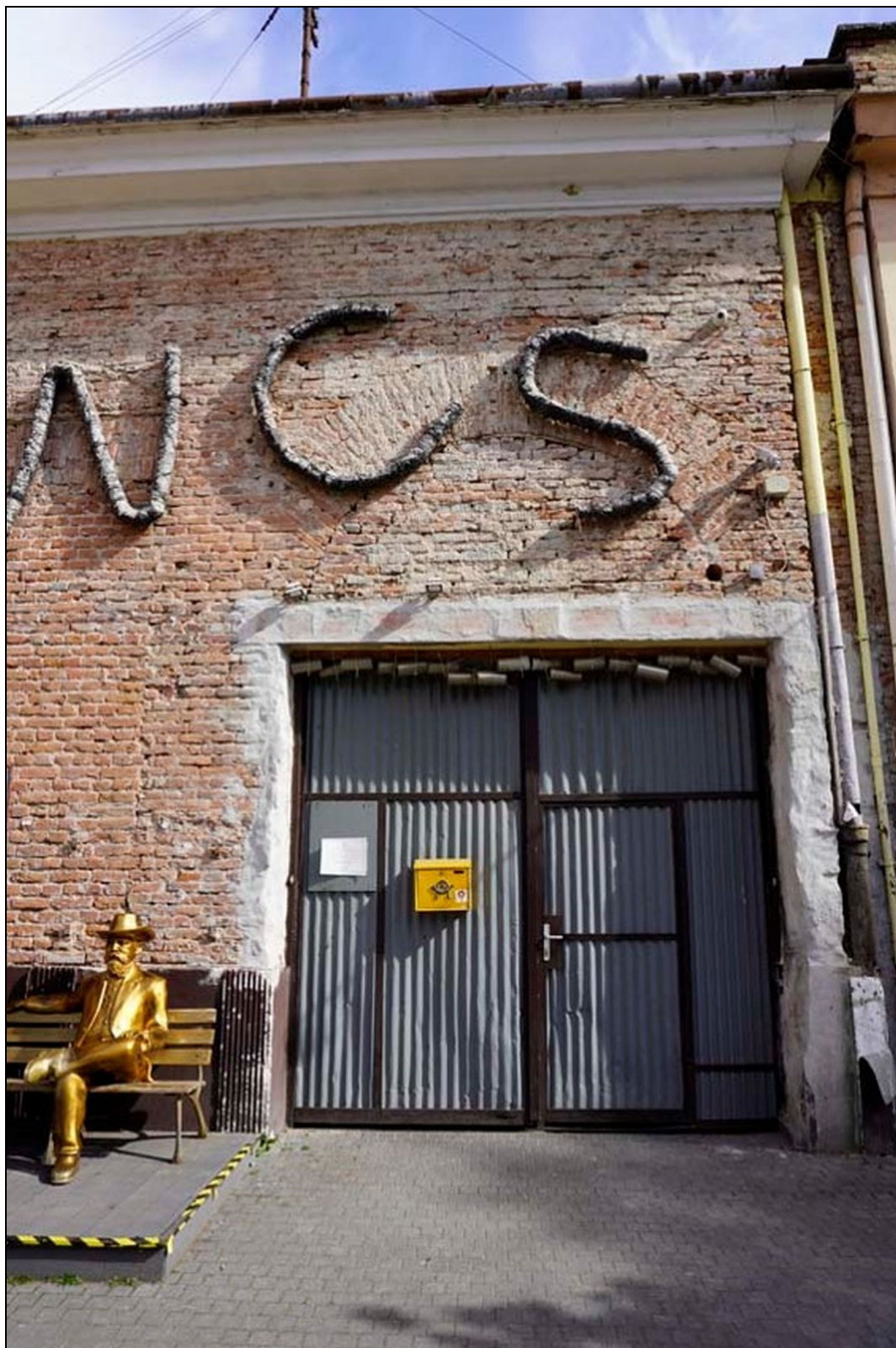
1. kép Eredetileg a kapuzat keskenyebb volt, később szélesítették ki 1
