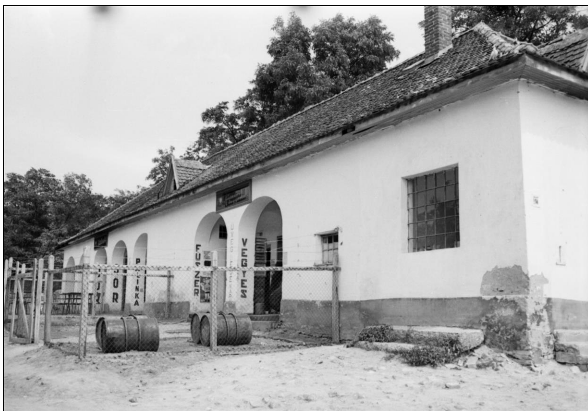
6. kép Az épület árkádos homlokzata 1964-ben Béres András felvételén 10
