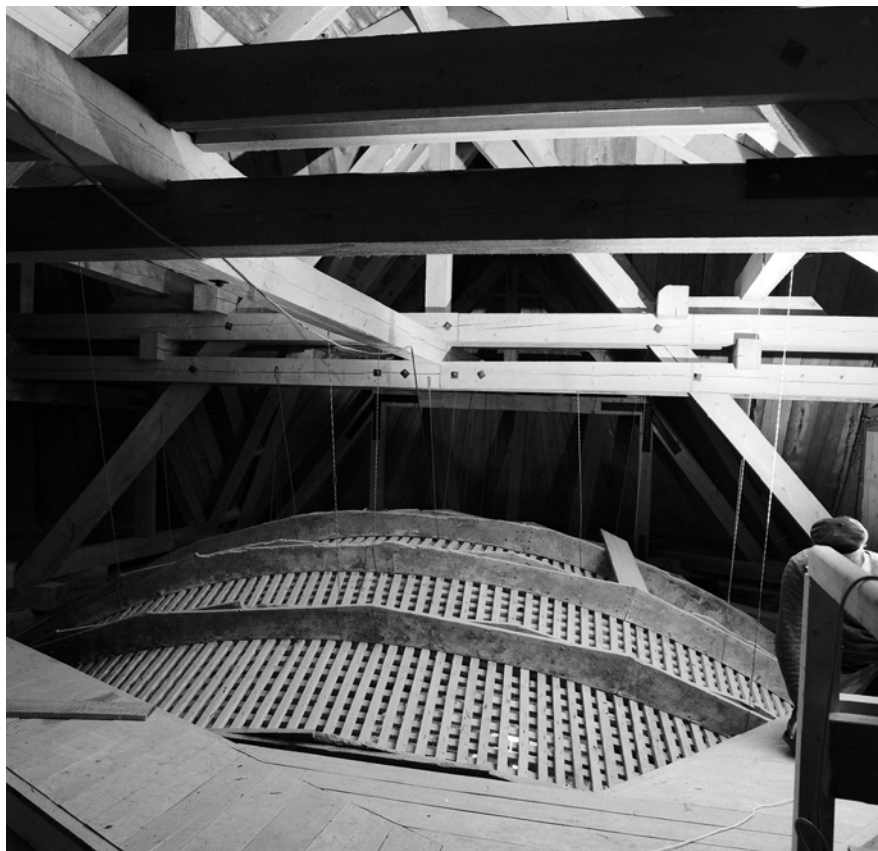
7. A tari római katolikus templomnak a tetőszerkezethez drótozott lécrácsos boltozata, 1981 © Barka Gábor felvétele, MÉM MDK, Fotótár, ltsz. 112.309aN
