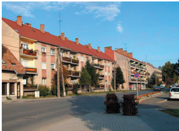
2. ábra. A vizsgált lakóépületek
