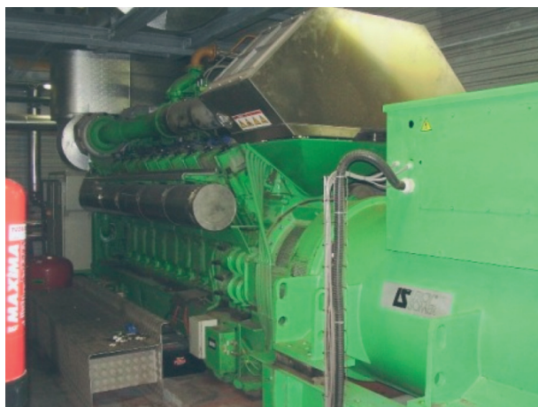
15. ábra: Gázmotor hajtotta generátor
