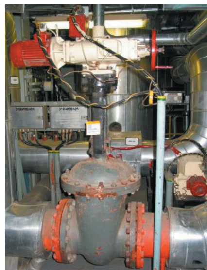
Motoros tolozár felépítése és képe
