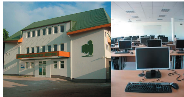
1. ábra. A felújított Mérnök-informatikai Központ
