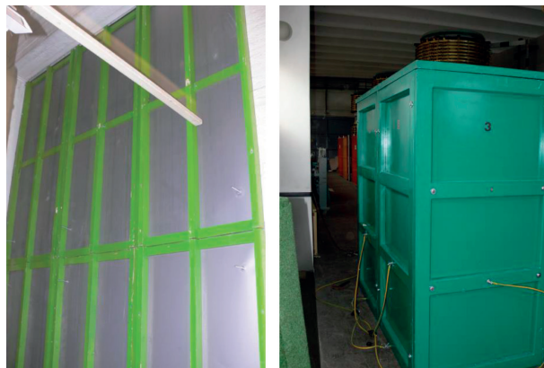
Egy fix és egy mobil árnyékoló rendszer. Árnyékolás középfeszültségű kapcsolótérben (ipari K+F projekt)
