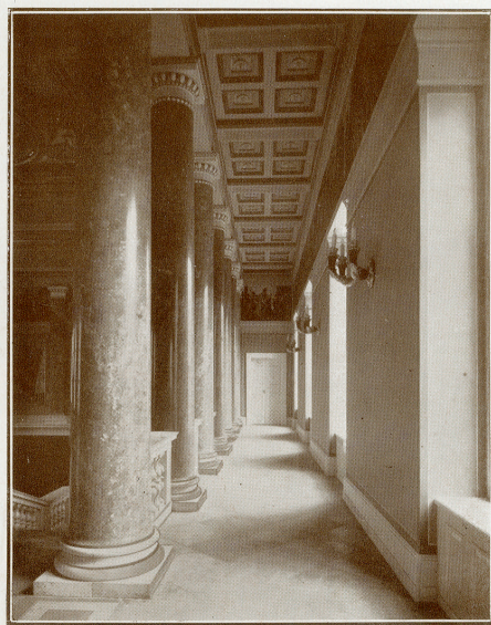
A főlépcsőház második emeleti oszlopcsarnoka a helyreállítás után.
