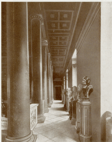
A főlépcsőház második emeleti oszlopcsarnoka a helyreállítás előtt.
