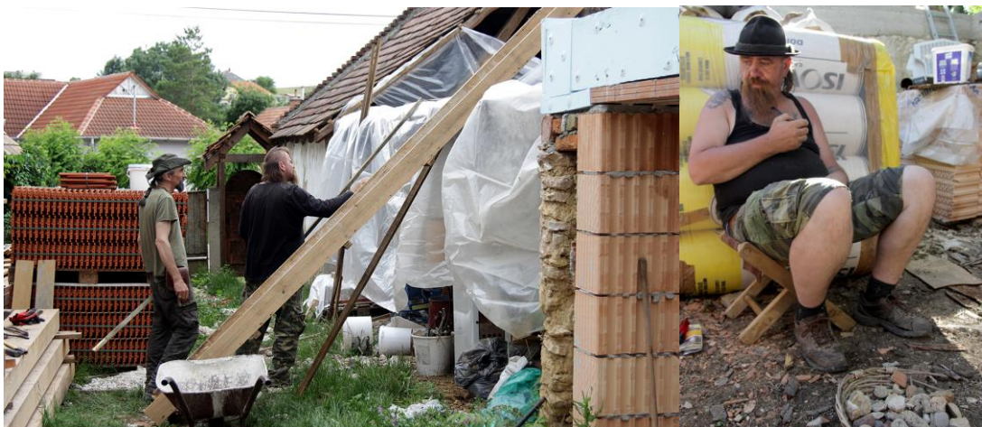
34-37. ábra: József a háza felújítás munkálatai közben (fotók: Bognár Szilvia)
