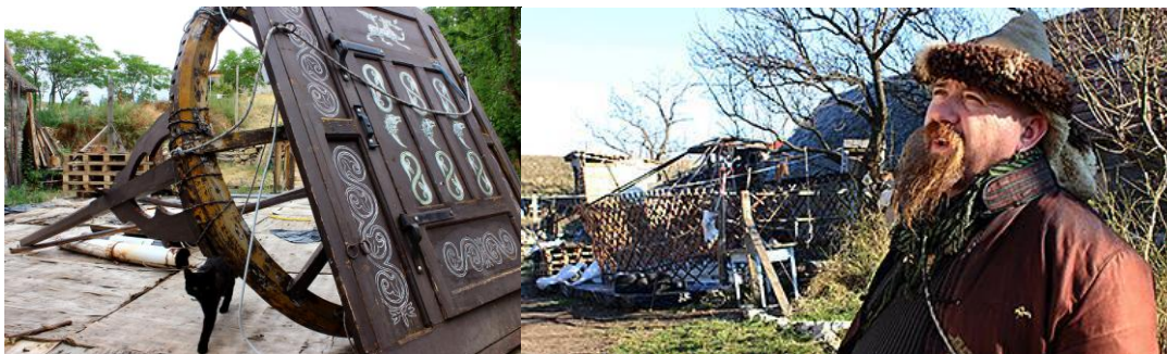
1-2. ábra: A régi, lebontott jurta megmaradt részei: a tündök és az ajtó, valamint a váz (fotók: Bognár Szilvia)
