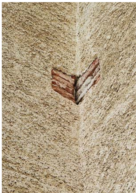
3. kép. A déli oldal nyugatról számított harmadik támpillérének elválása a hajófaltól
