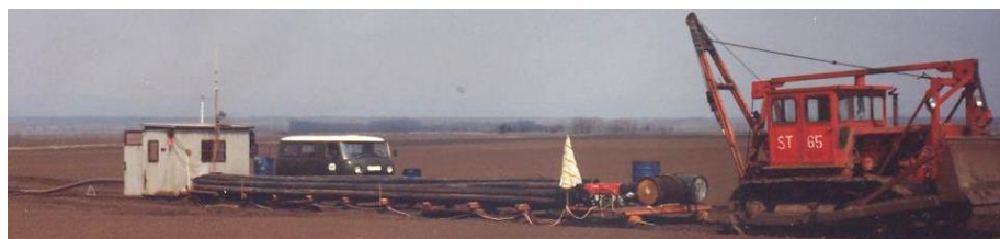
2.2.2.6 ábra: PE gázvezeték építés
