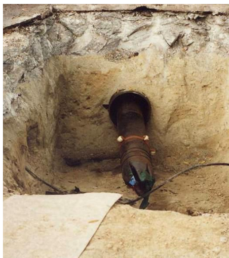
3.1.1 ábra: PE cső deformáció mentes befűzése
