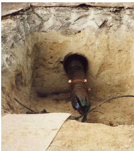
3.1.1 ábra: PE cső deformáció mentes befűzése
