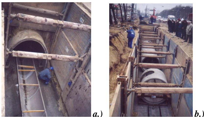
3.1 ábra: Szennyvíz főgyűjtő építése Budapest, Mázsa tér:
