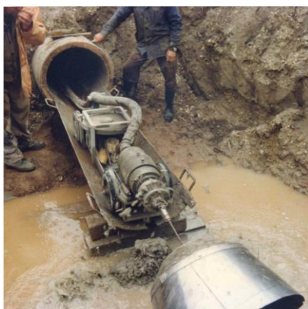
3.5.1 ábra: Cementhabarcs bélelő /TATE/ eljárás
