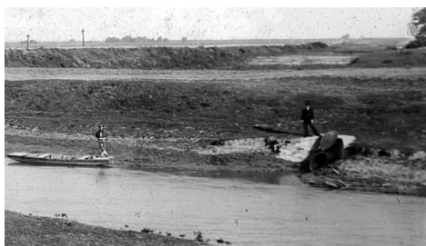
A kanaki alagsó kivezetése a Berzava-csatornába (Az előbbi fénykép részlete)
