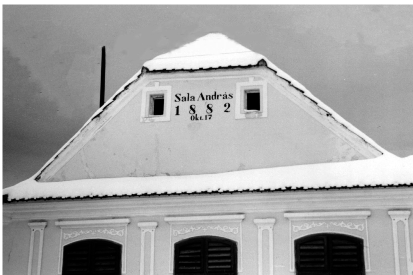
A Sala-ház homlokzata a 2000-es évek közepén
