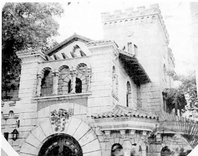
A Centro Nacional del Fondo Geológico épülete Havana Miramar nevű városrészében 1975–1981 között
