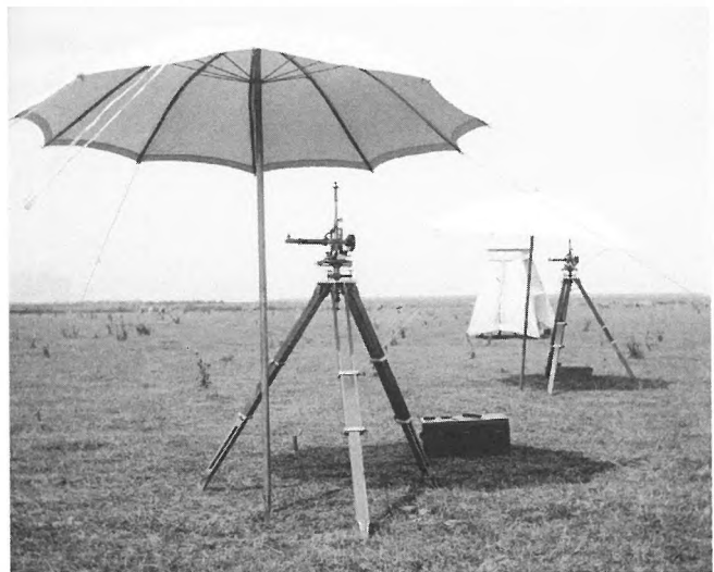
3. ábra. Mágneses teodolitok észlelésre készen
